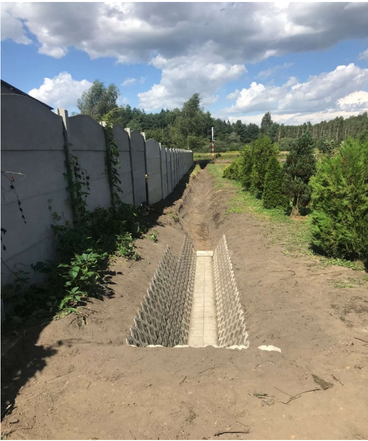
FOTO: Wykonanie rowu odwadniającego drogę główną i teren przyległy w sołectwie Szudłów.
