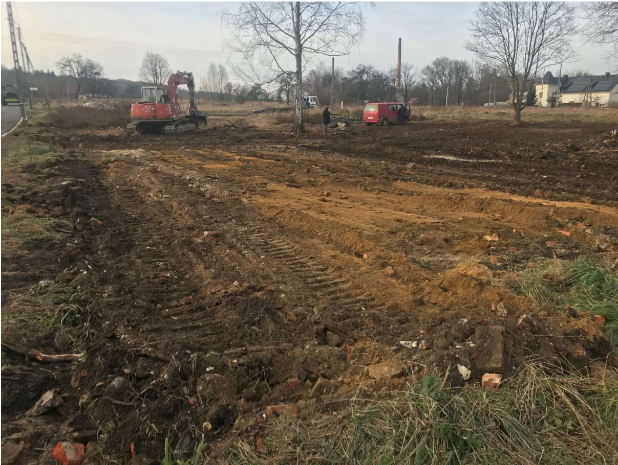
FOTO: Rozbiórka obiektu budowlanego wraz z niwelacją terenu w sołectwie Sztyłów
