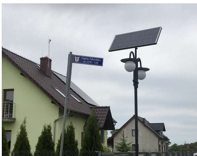
FOTO: Montaż lampy solarnej na drodze w Ligocie Tułowickiej
