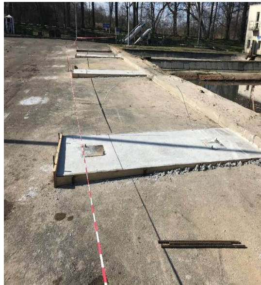
FOTO: Montaż wagi najazdowej (PSZOK) w Tułowicach
