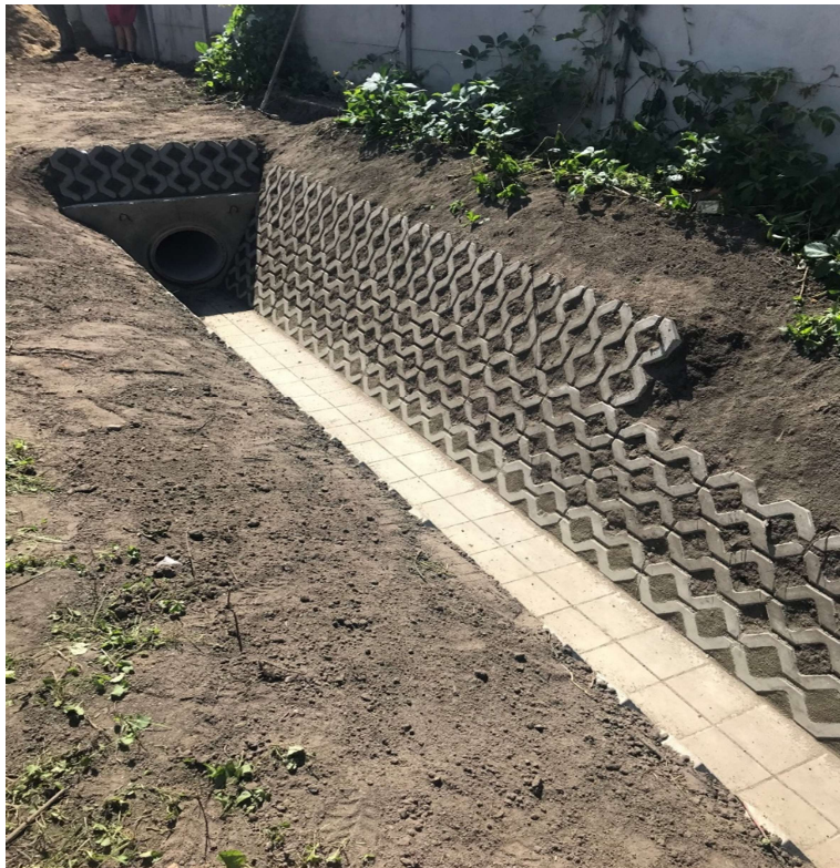
FOTO: Wykonanie rowu odwadniającego drogę główną i teren przyległy w sołectwie Szudłów.
