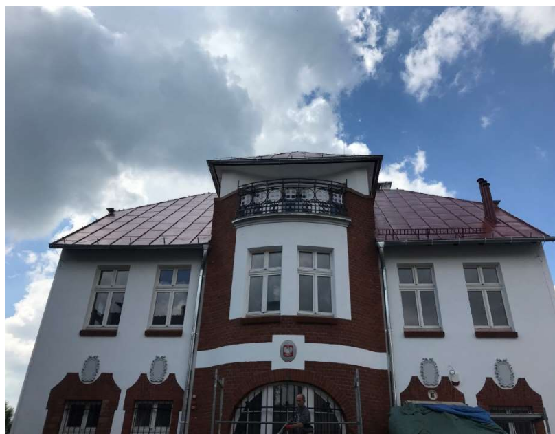
FOTO: Poczta w Tułowicach, wykonanie remontu pokrycia dachowego i elewacji.
