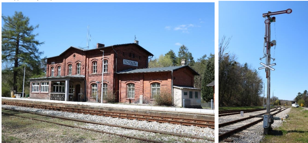
Ryc. 11 Stacja kolejowa w Szydłowie – budynek dworca; Ryc. 12 Stacja kolejowa w Szydłowie – semafor kształtowy dwuramienny
