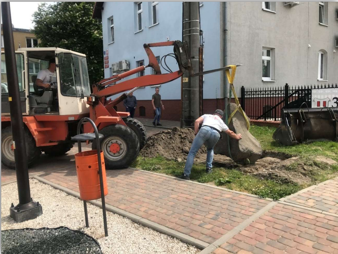
Foto: Wykonanie zagospodarowania terenu przed budynkiem Urzędu Miejskiego w Tułowicach
