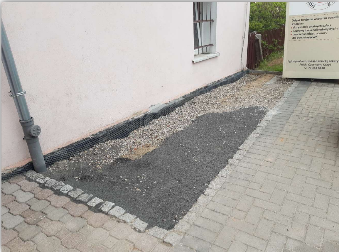
Foto: Wykonanie izolacji przeciwwilgociowej ścian budynku świetlicy w sołectwie Skarbiszowice.
