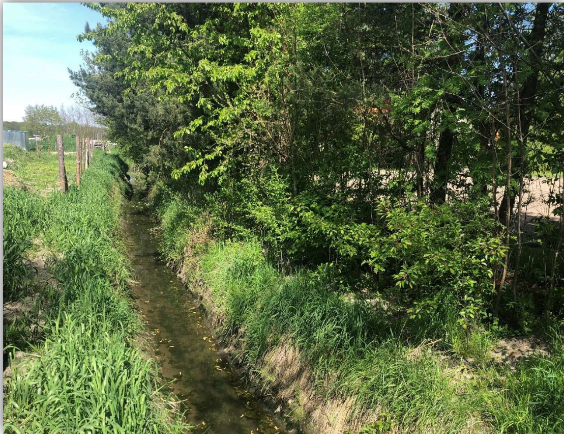
Foto: Uporządkowanie rowu odwadniającego przy ul. Jagodowa
