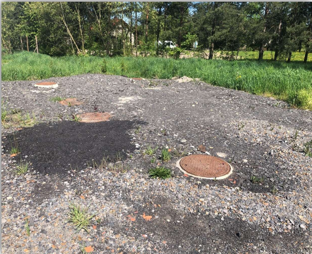
Foto: Utwardzenie terenu przy zbiornikach osadowych ul. Jagodowa.
