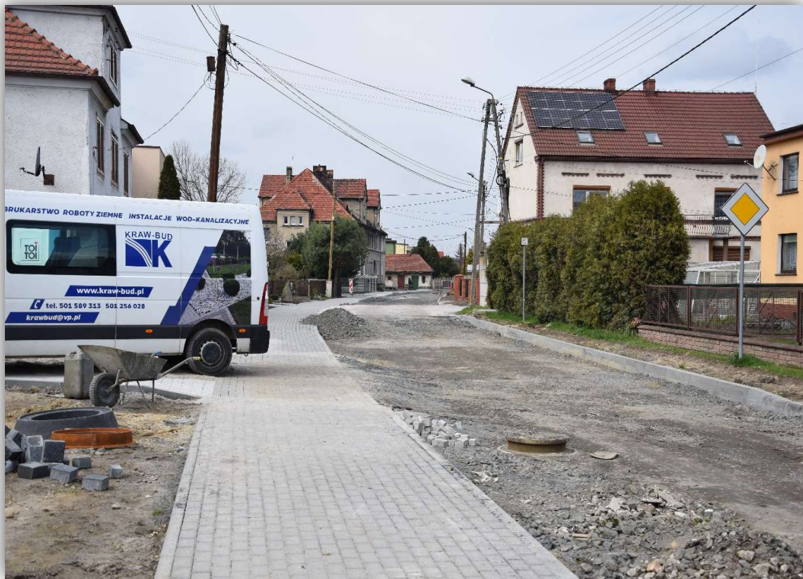
Foto: Ulica Przedszkolna w kierunku do przejazdu kolejowe.
