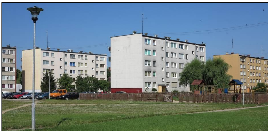
Rysunek 4 Infrastruktura mieszkaniowa Spółdzielni Mieszkaniowej w Łambinowicach na terenie Gminy Tułowice
