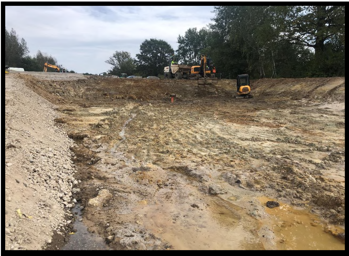
Foto: Prace ziemne, budowa zbiornika retencyjnego w Sołectwie Szydłów.
