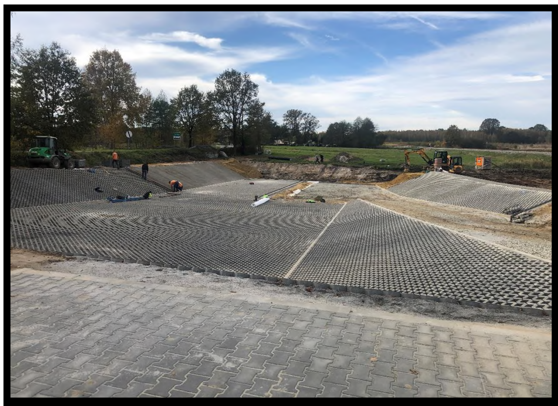
Foto: Budowa zbiornika retencyjnego w Sołectwie Szydłów – montaż płyt ażurowych.
