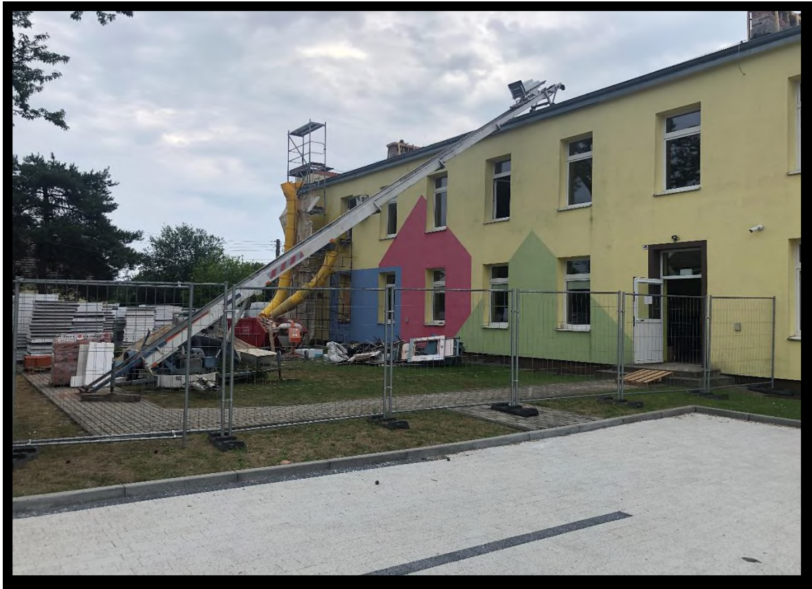
Foto: Przebudowa budynku przedszkola w Tułowicach – docieplenie stropodachu budynku
