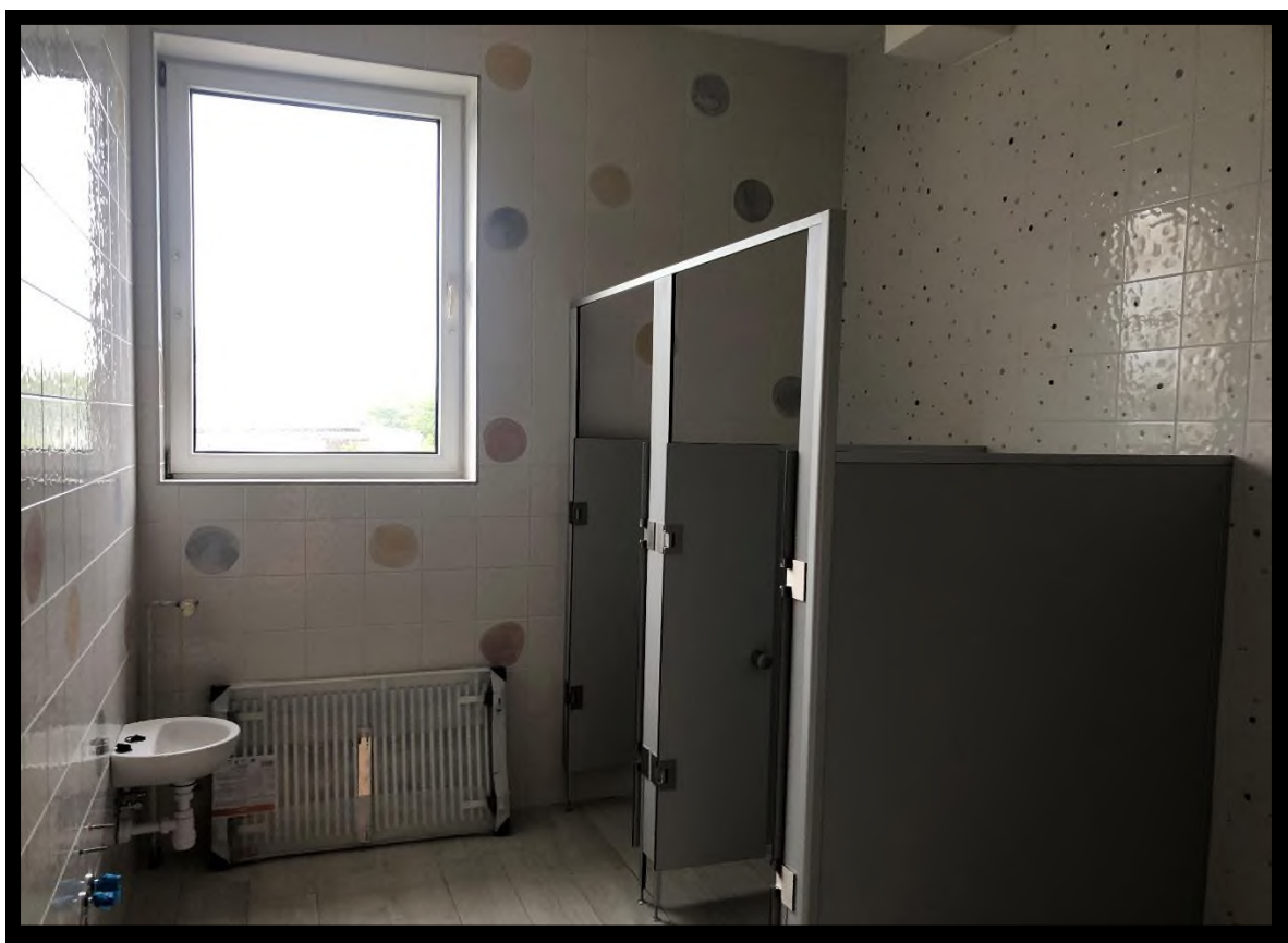
Foto: Przebudowa budynku przedszkola w Tułowicach – sanitariat
