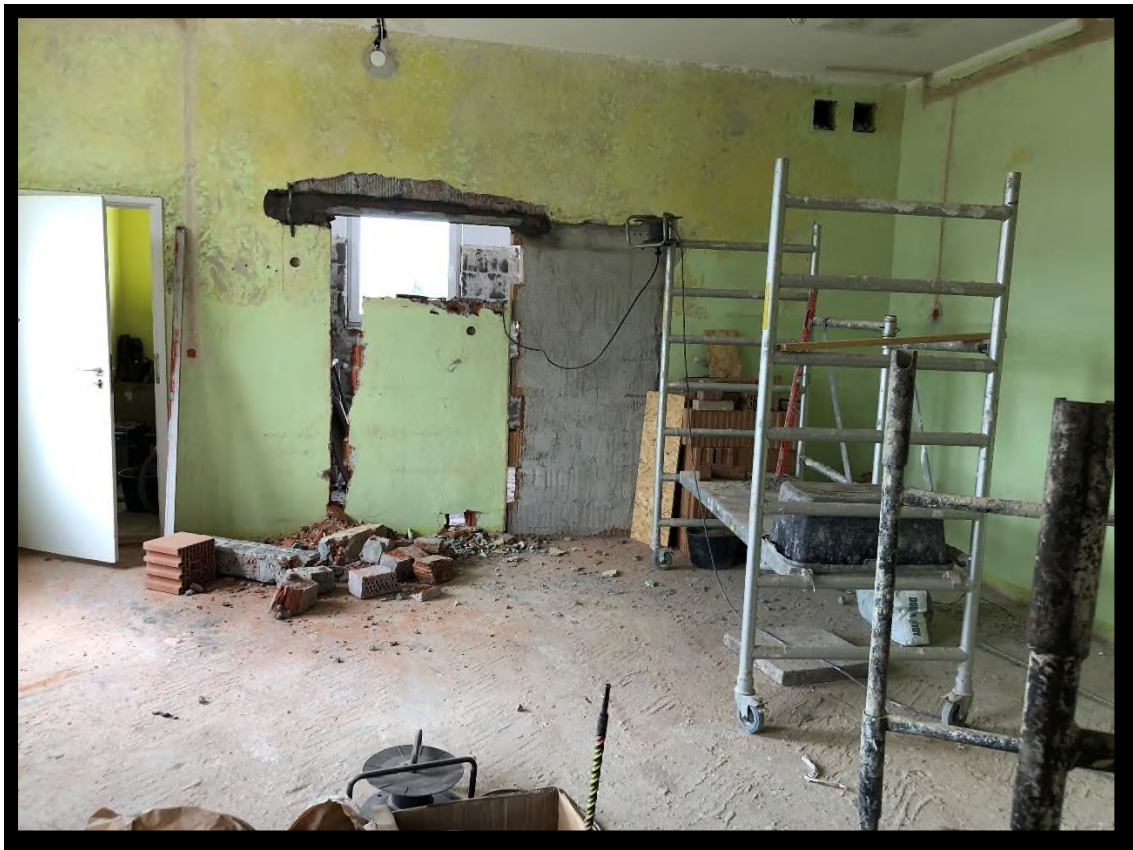
Foto: Przebudowa budynku przedszkola w Tułowicach
