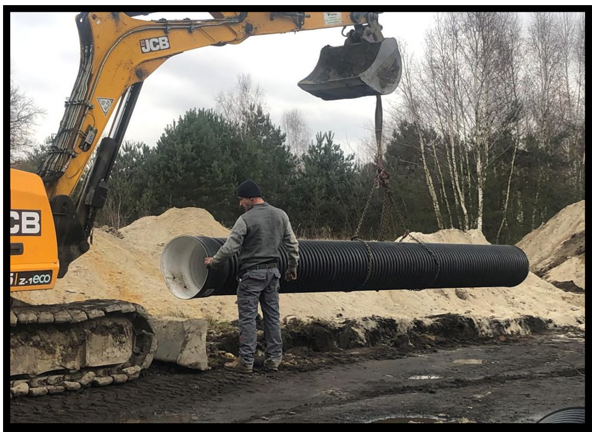
Foto: Przebudowa dwóch dróg gminnych położonych w Sołectwie Szydłów – budowa sieci kanalizacyjnej ul. Sosnowa
