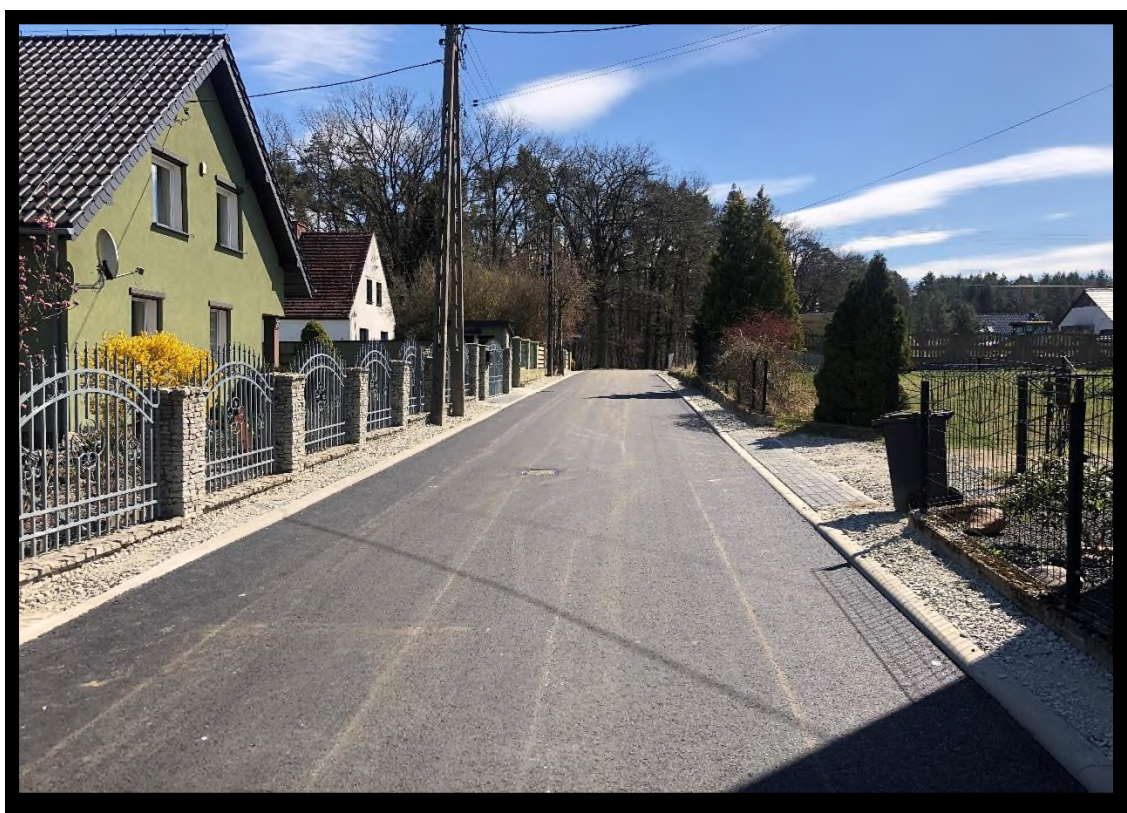
Foto: Przebudowa dwóch dróg gminnych położonych w Sołectwie Szydłów – ul. Sosnowa
