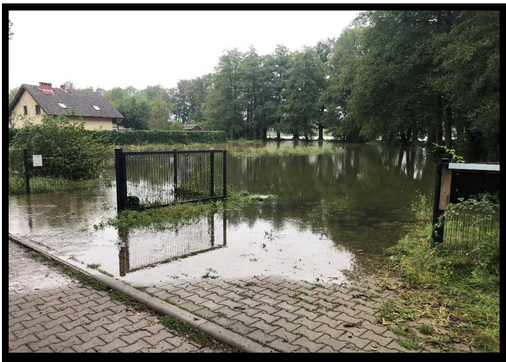
Foto: Wrzesień 2024 r. przepompownia ścieków w Sołectwie Tułowice Małe zalana przez wody powodziowe.
