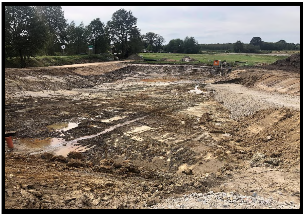
Foto: Prace ziemne, budowa zbiornika retencyjnego w Sołectwie Szudłów.
