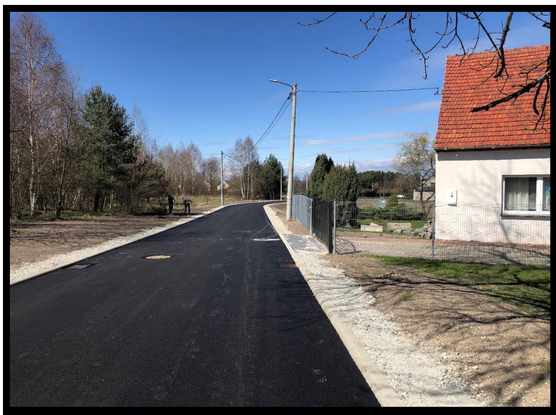
Foto: Przebudowa dwóch dróg gminnych położonych w Sołectwie Szydłów – ul. Sosnowa
